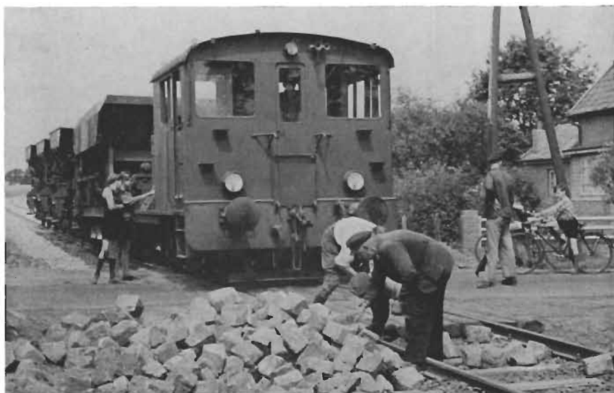
Bauzug am Bahnübergang Ohechausee in Garstedt. AKN, V 11, 27. 6. 1952
